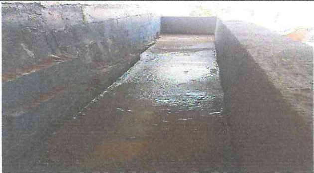
Foto1: inicio con reparación de cuneta de concreto
