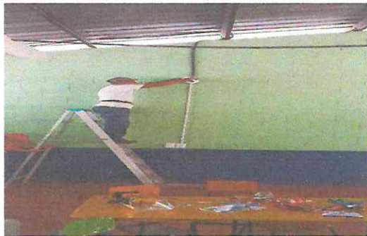
Foto 5: instalación de energía eléctrica
