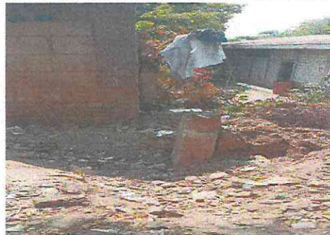
Foto 6: construyendo el muro perimetral
