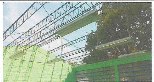
Foto 4: anclaje de costaneras de metal sobre jois
