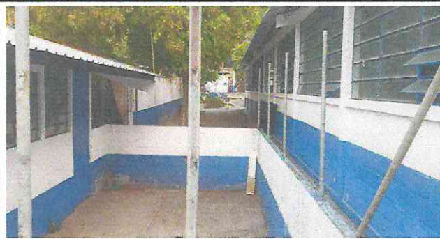
Foto 3: espacio donde se colocará la baranda de metal
