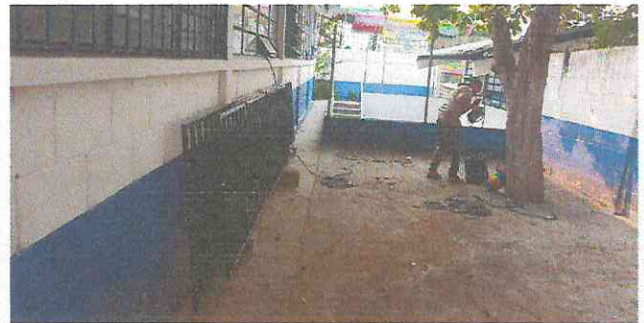
Foto 2: reparando la baranda de metal
